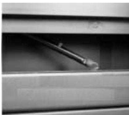
La regolazione deve essere eseguita nel seguente modo: a) accendere il fuoco nel camino; b) regolare la vite a farfalla in maniera tale che non si accumuli fumo nella camera di combustione, nè vi deve essere un eccessivo tiraggio.
